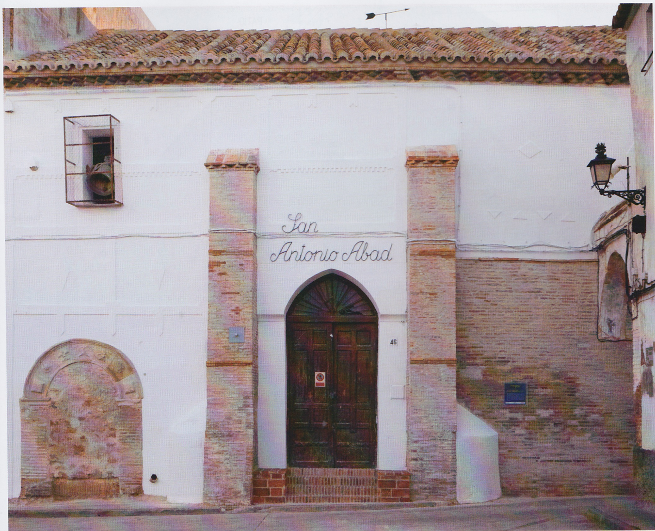
▲ Fachada y acceso a la ermita de San Antón de Híjar desde la plaza homónima, tras las obras realizadas en 2017.
